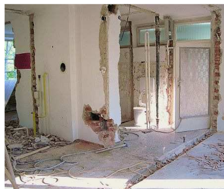
Die Wände fallen...
