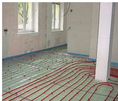
Verlegen der Fußbodenheizung
