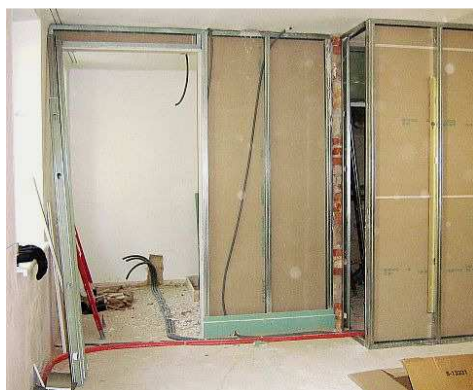
Aufstellen der Waschräumwand
